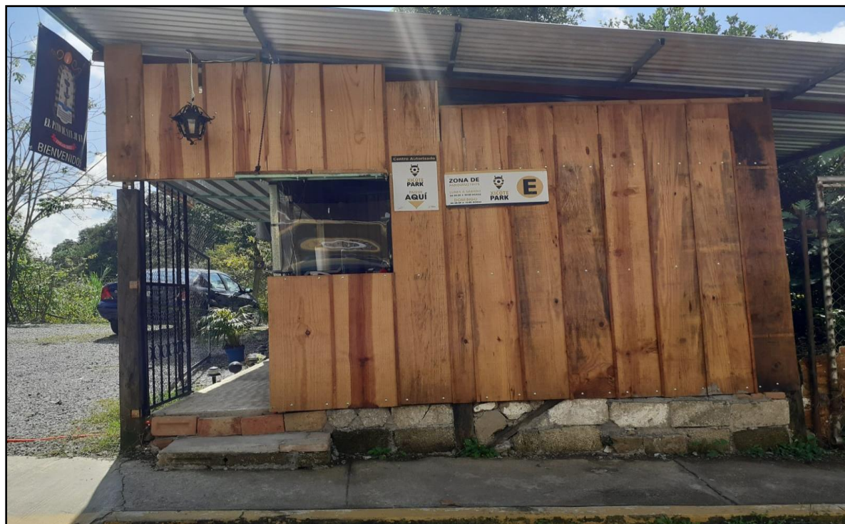
27) Deltawash; ubicado en Calle Guadalupe Victoria.
